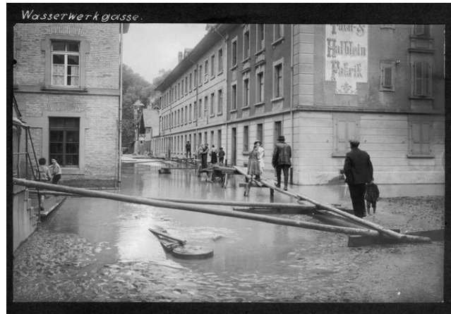
Abbildung 5 Alte Aufnahme der Wasserwerkergasse, während einer Überschwemmung www.mattequartier.li
