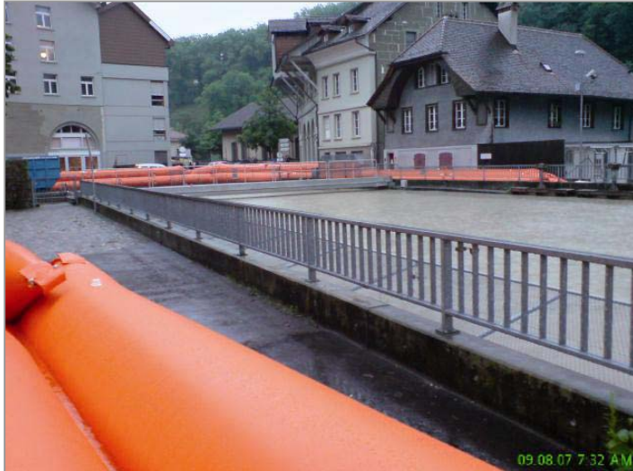
Während des Hochwassers 2007 setzte die Feuerwehr Beaver-Schläuche erfolgreich als «mobile Ufererhöhung» ein.
