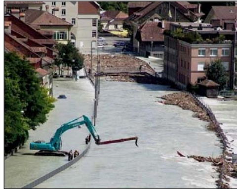
Leichter Mobil-Kran bei der Schwemmholzentnahme während des Hochwassers 2005. Durch die Verstärkung der Interventionsplätze können leistungsfähigere und schwerere Maschinen eingesetzt werden.
