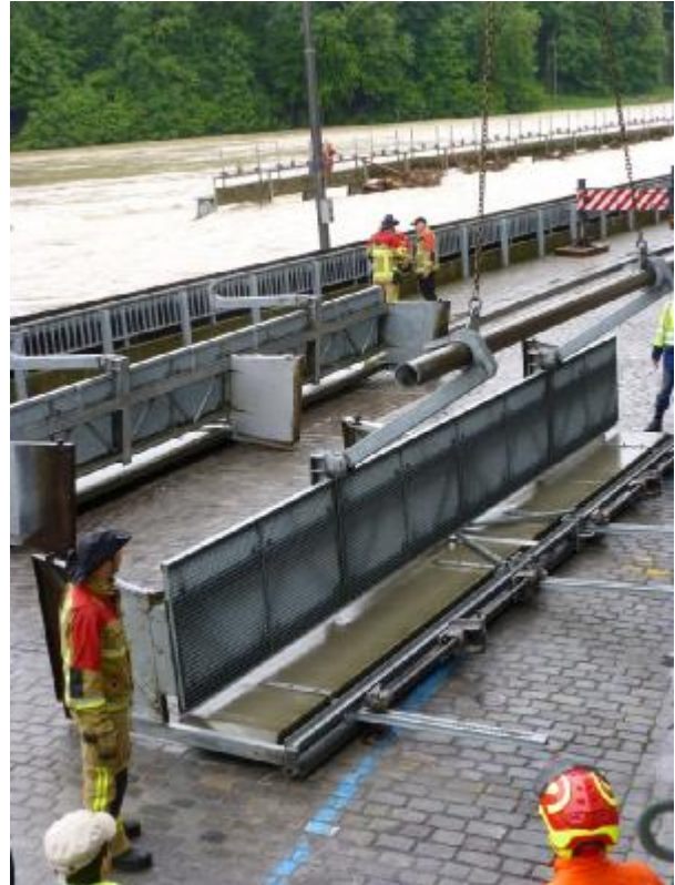
Den Kran aufzustellen und die Dammbalken aus der reissenden und hoch gehenden Aare zu ziehen ist eine schwierige und gefährliche Arbeit.
